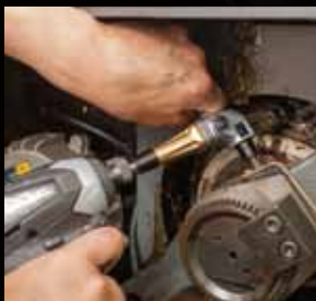
○機械の入りにくい箇所での作業
